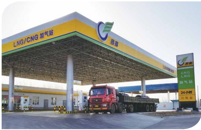
在內地的液化石油氣加氣站
